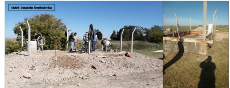
24/04/2019. Construcción de la estación limnimétrica EM06
