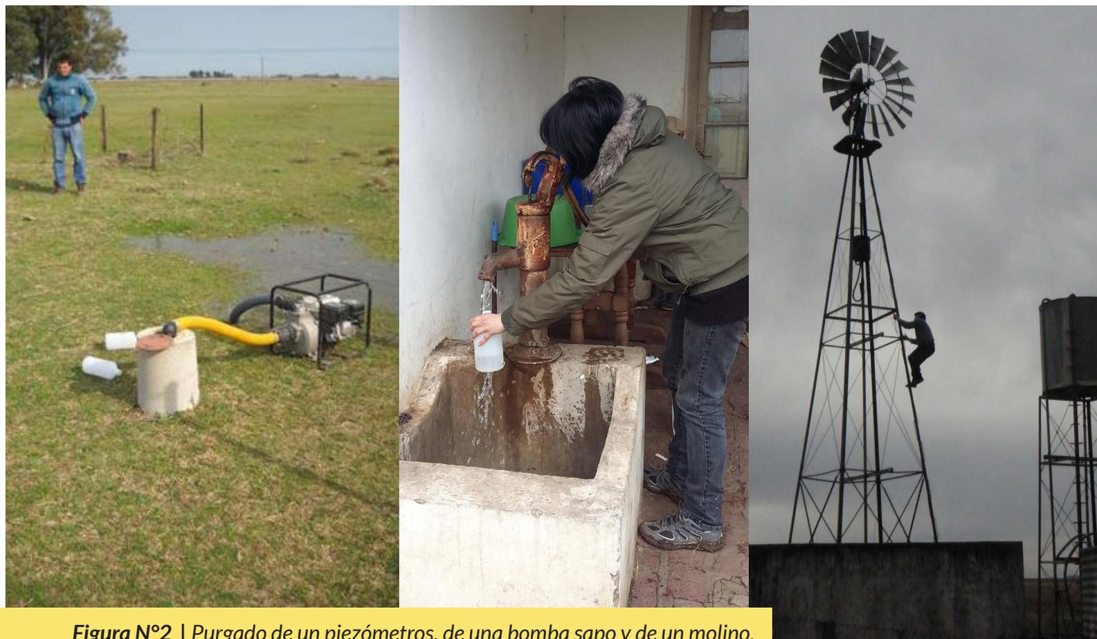
*Figura N°2 | Purgado de un piezómetros, de una bomba sapo y de un molino.*
