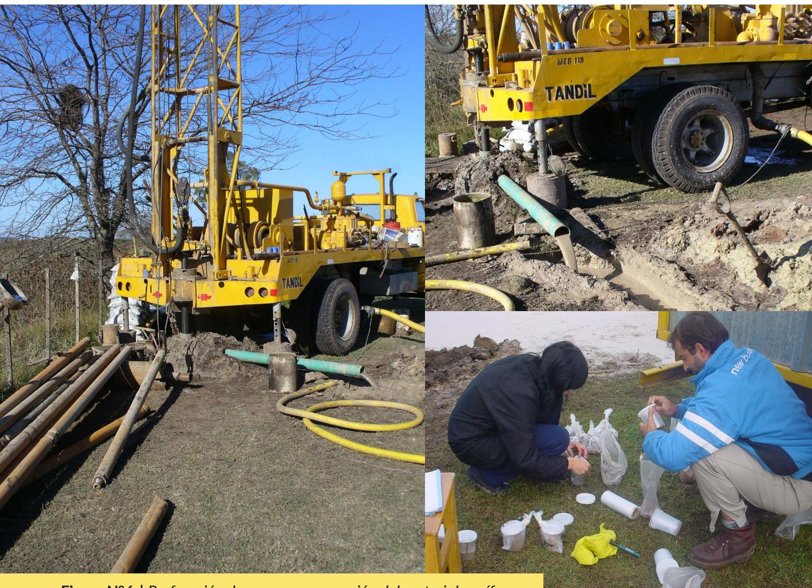
**Figura N°6** | Perforación de pozo y recuperación del material acuífero.
